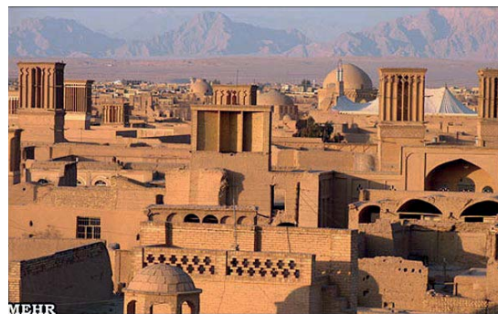
تصویر ۱. نمایی از بادگیرهای خانه‌های کویری در شهر یزد. بهره‌مندی از قابلیت‌های بستر برای تأمین شرایط آسایش، از راهکاری رایج در معماری مسکونی گذشته ایران به شمار می‌آید (www.irandesert.com).
